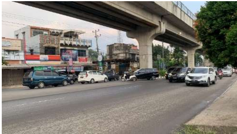
Gambar VI. 4 Kondisi jalan Kol. H. Burlian
