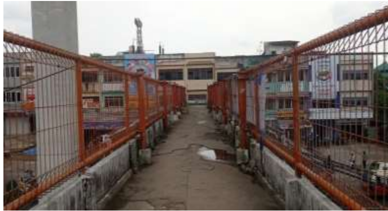
Gambar VI. 9 Kondisi jembatan penyeberangan orang di Jl. Kol H. Burlian
