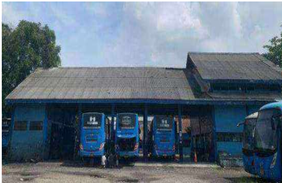
Gambar IV. 13 Fasilitas Pemeliharaan dan Perbaikan Sumber : Dokumentasi Penyusun, 2021
