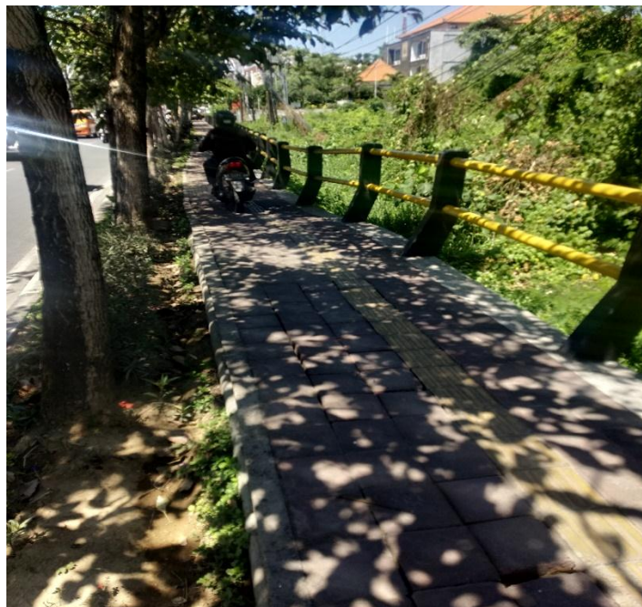
Gambar 5.23 Pengendara Sepeda Motor Menyalahgunakan Trotoar pada STA 0 + 800 Jalan Sunset Road (Sumber: Hasil Survei, 2019)
