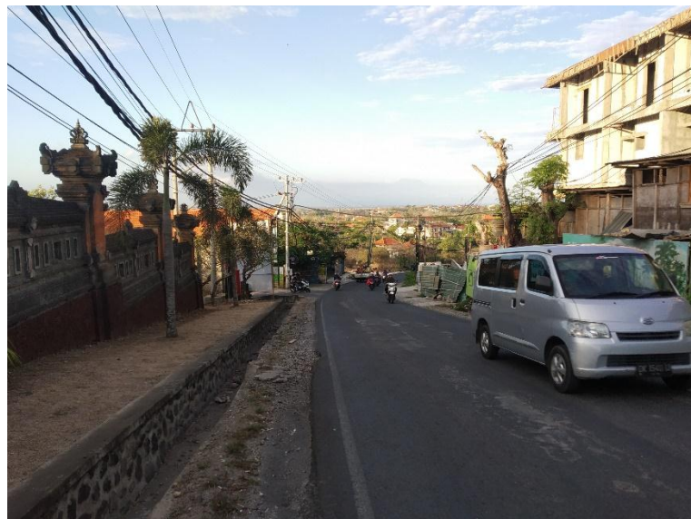
Gambar 5. 53 Kondisi Eksisting Marka Tepi Yang Memudar (Sumber: Hasil Survei, 2019)
