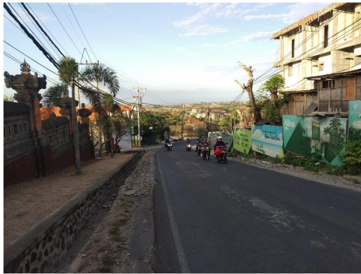
Gambar 5.38 Bahu jalan dan drainase pada STA 4 + 200 Jalan Dharmawangsa (Sumber: Hasil Survei, 2019)
