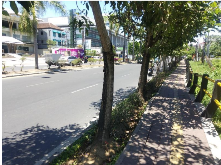
Gambar 5.22 Trotoar pada STA 0 + 800 Jalan Sunset Road (Sumber: Hasil Survei, 2019)
