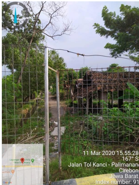
Gambar IV.1 Gambar pagar yang telah rusak
