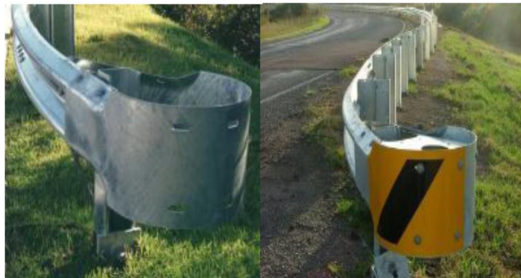
Gambar IV. 3 Contoh terminal jenis bullnose dan modified eccentric loader terminal (MELT) Sumber : Analisis TIM PKP Gempol – Pandaan Tol
