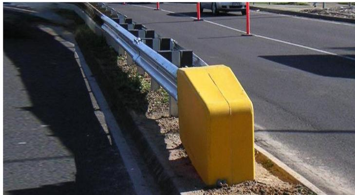
**Gambar III. 37** Contoh *extension median attenuator*
