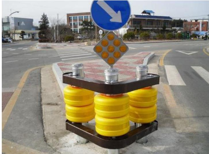
**Gambar III. 38** Contoh *roller barrier*
