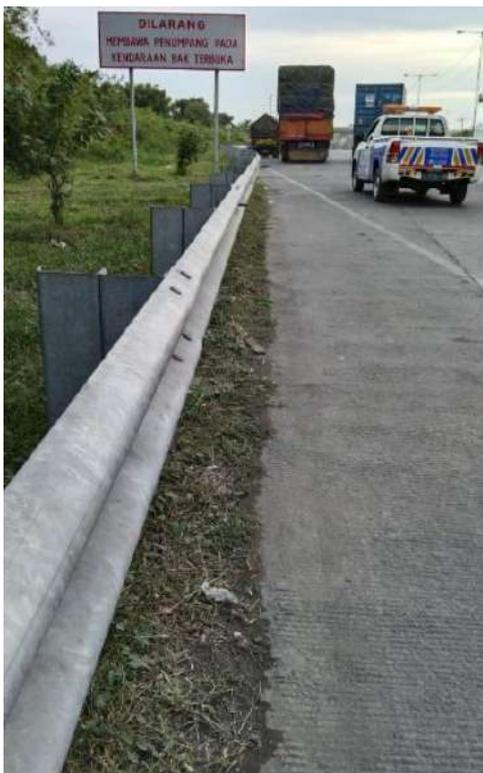
Gambar III. 22 Pengaman Pemakai Jalan Pada Ruas Jalan Tol Surabaya – Gresik menggunakan Guard Rail
