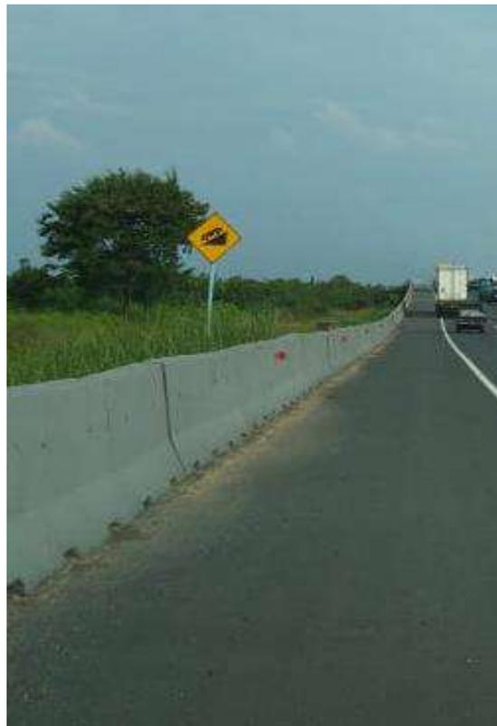
Gambar III. 21 Pengaman Pemakai Jalan Pada Ruas Jalan Tol Surabaya – Gresik menggunakan parapet
